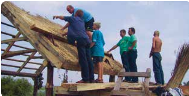
Niedru jumta likšanas ievirzē nojumei Papes ezera krastā tika uzlikts īsts jumts
